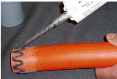
Apply BonDuit® Adhesive
